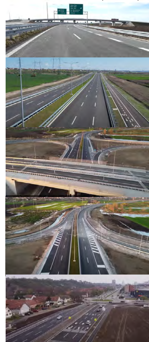
Slike 3-7. Izvedeno stanje saobraćajnice
